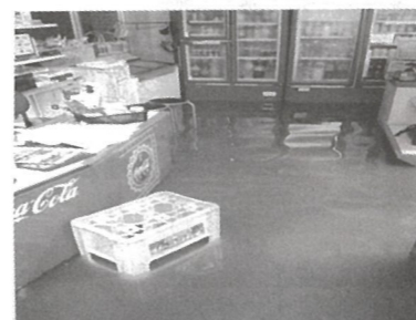
▲ 豪雨により浸水した店内
